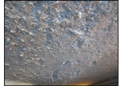
Photo N° 663 ECH-N°1 FLOCAGE -- LOCAL POUBELLE Plafonds blanc cotonneux
